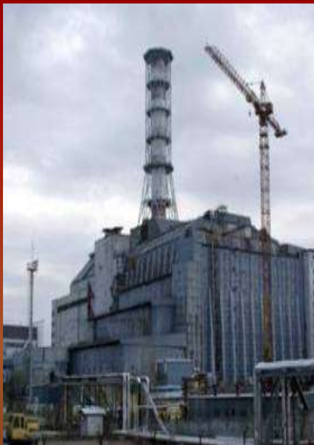
Аварийный энергоблок № 4 Чернобыльской атомной электростанции (1986 г.)
